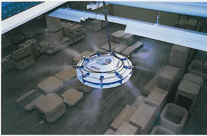
Holz braucht Luftbefeuchtung. MERLIN konzipiert hierfür flexible Luftbefeuchtungsanlagen für Tischler ebenso wie für Großbetriebe.
