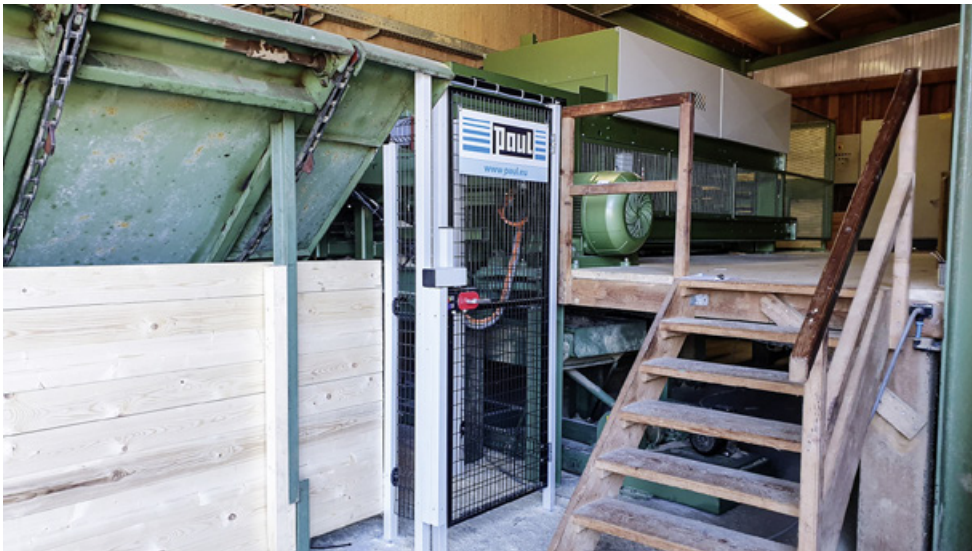
Der 90 kW starke Motor sorgt für ausreichend Leistung der Paul-Besäumkreissäge des Typs KME3 beim Sägewerk Kraus
